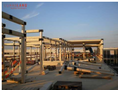
LLBT-Gerüst im Aufbau
