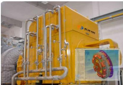
*Komplett in SolidWorks konstruiert: ELIN EBG Generator mit 750 Einzelteilen und 20.000 kVA Leistung für den Einsatz in Biomasseheizkraftwerk. Rechts im Bild das Modell der Erregerereinheit*
