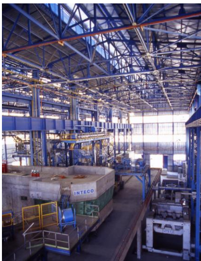
Übersicht über die Sekundärmetallurgiehalle – real
