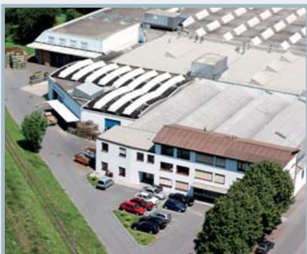
Luftaufnahme des Fulterer Stammwerkes in Lustenau
